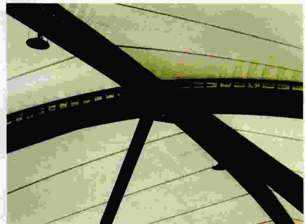
照片 8: 钢架梁与钢撑间连接实况(二)
