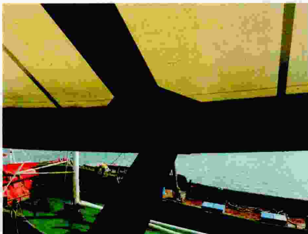
照片 7: 钢架梁与钢撑间连接实况(一)
